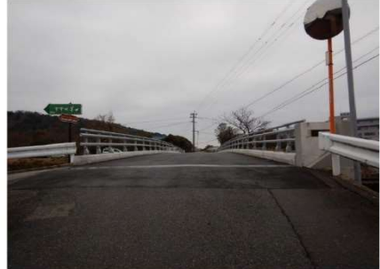
舗装、地覆、防護柵改良後
