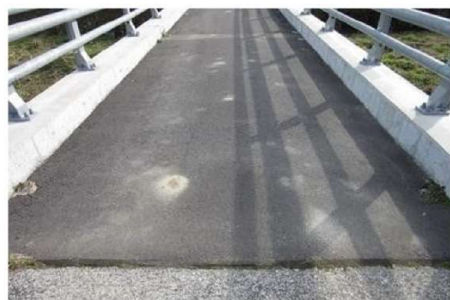
防護柵改良後
