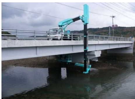
写真 1 橋梁定期点検状況（イメージ）
