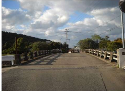
舗装、地覆、防護柵改良前
